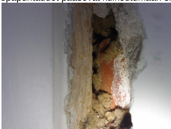
Kuvat 14 ja 15. Karmin vieressä on seinäeristeenä mineraalivilla. Villassa ja karmipuussa on tummentumia ilmavuotojälkinä.
