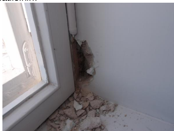
Kuvat 14 ja 15. Karmin vieressä on seinäeristeenä mineraalivilla. Villassa ja karmipuussa on tummentumia ilmavuotojälkinä.
