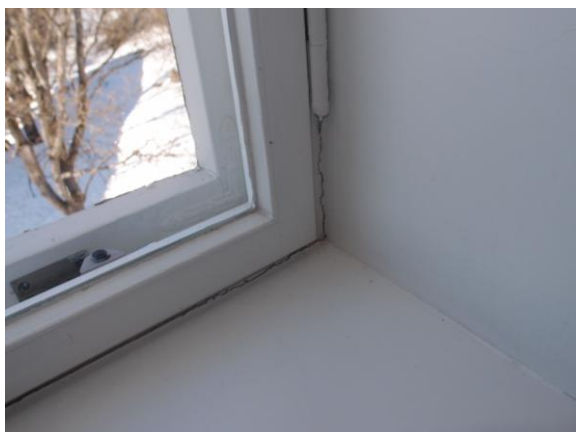
Kuvat 12 ja 13. Karmipuun ja seinän välissä rakoja, joista ulkoseinärakenteen epäpuhtaudet pääsevät kulkeutumaan sisätiloihin.
