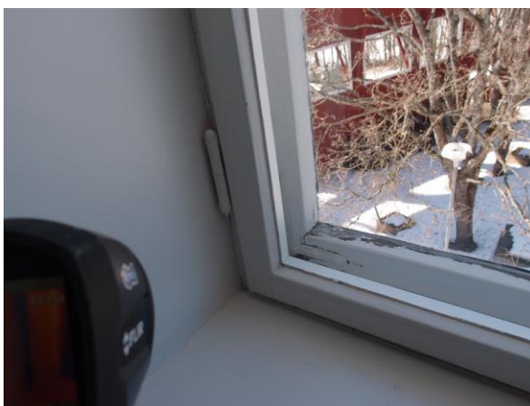
Kuvat 7 ja 8. Ikkunoiden ulkopuitteiden alareunoissa ja karmien alareunoissa on lahovaurioita.
