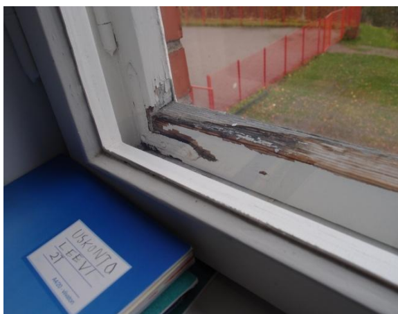
Kuvat 7 ja 8. Ikkunoiden ulkopuitteiden alareunoissa ja karmien alareunoissa on lahovaurioita.
