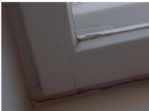
Kuvat 12 ja 13. Karmipuun ja seinän välissä rakoja, joista ulkoseinärakenteen epäpuhtaudet pääsevät kulkeutumaan sisätiloihin.
