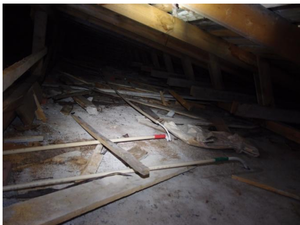
Kuvat 12 ja 13. Yläpohjan roinaa ja avoimia sähköläpimenoja.
