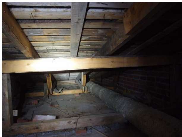
Kuvat 1 ja 2. Vesikaton vuotokohta ja alapuolen paloermanto.
