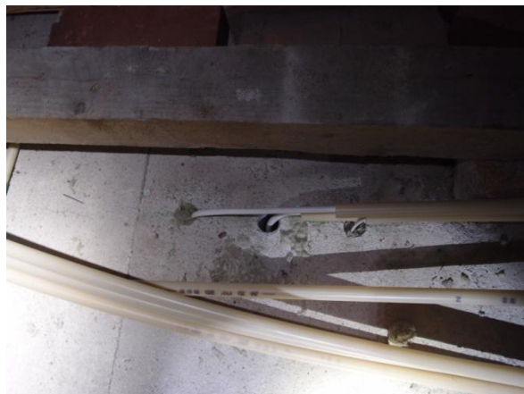
Kuvat 12 ja 13. Yläpohjan roinaa ja avoimia sähköläpimenoja.
