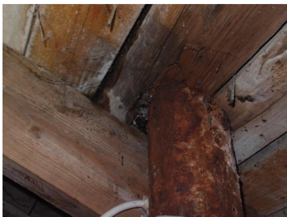
Kuvat 14 ja 15. Linnunpesän risukasa ja vuotava kattoläpimeno.
