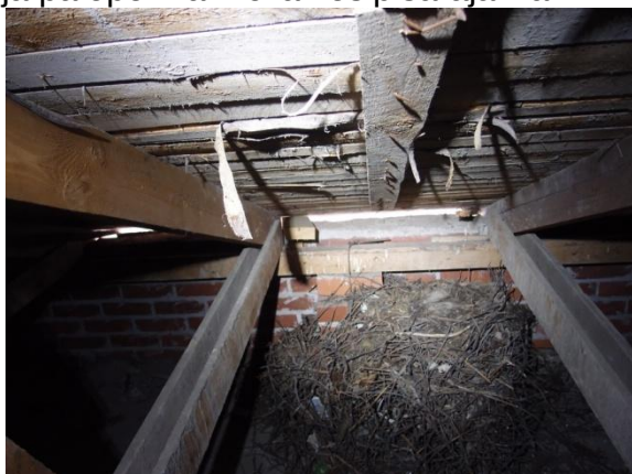
Kuvat 14 ja 15. Linnunpesän risukasa ja vuotava kattoläpimeno.
